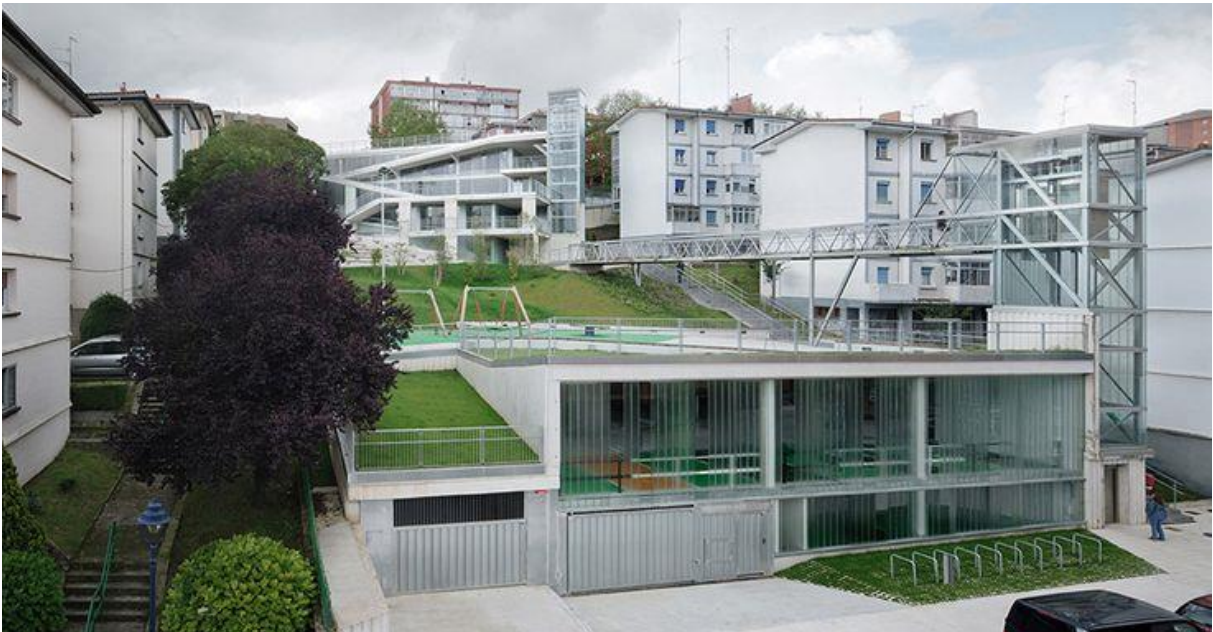
Arriba, edificio de aparcamientos en Larratxo (Donostia, Estudio Urumea). Abajo, edificio de aparcamientos, parque y conexión accesible en Galtzaraborda (Errenteria, VAUMM).
